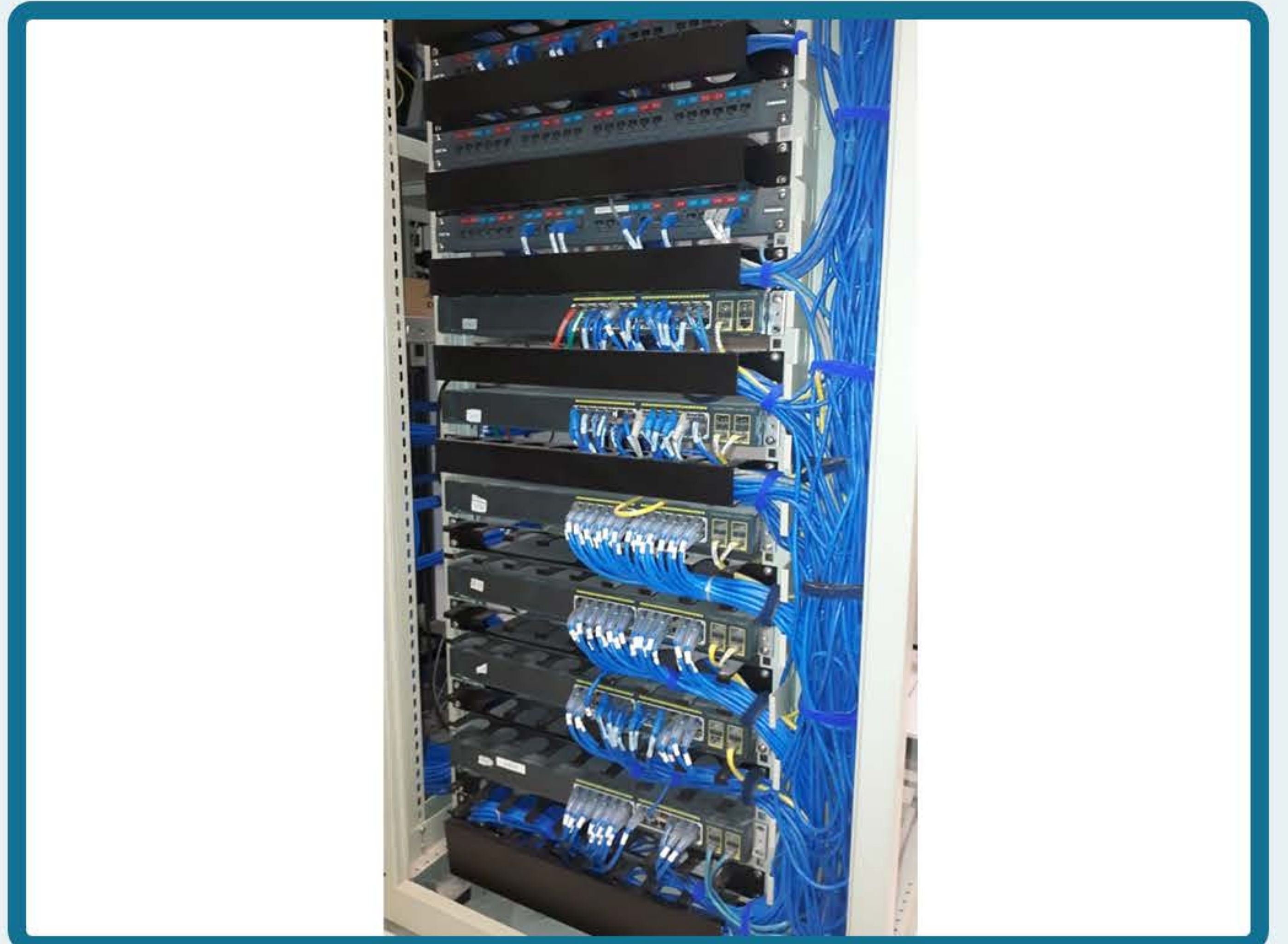
Montagem de Rack Cabeamento Estruturado
