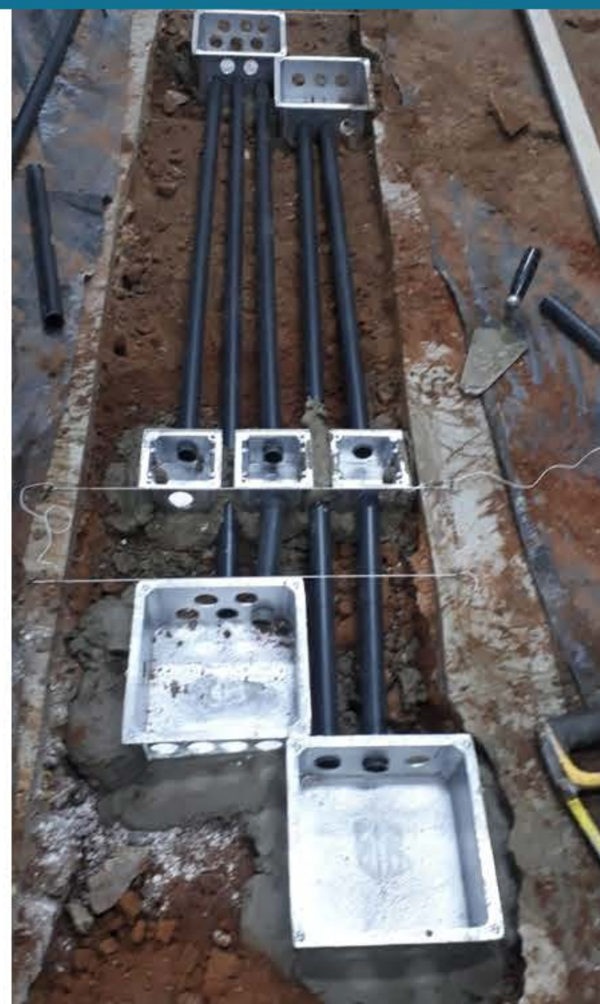
Obras de Infraestrutura
