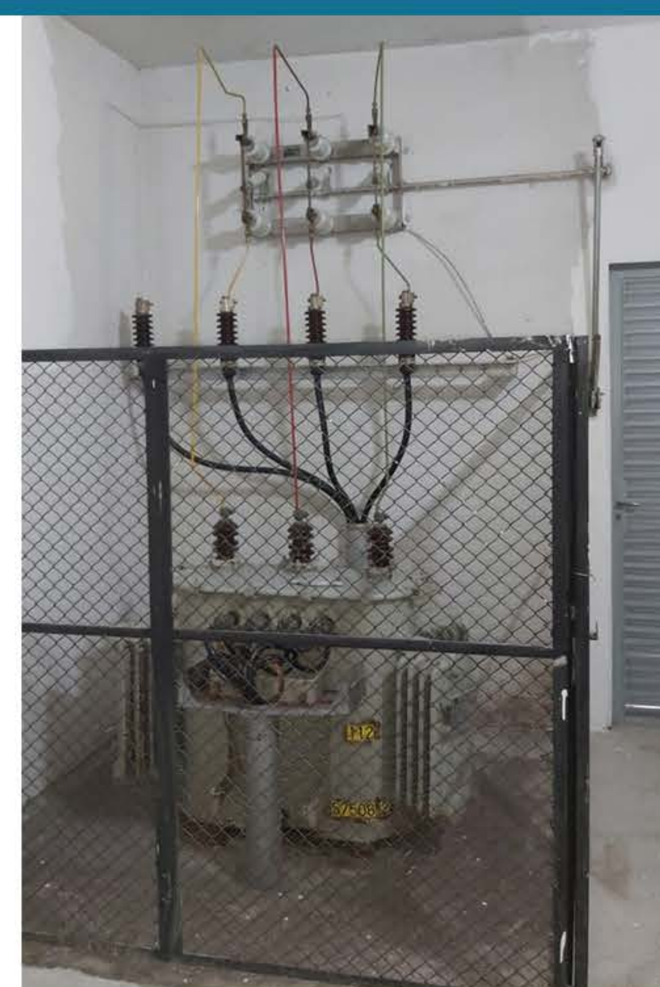
Manutenção Subestação Abrigada
